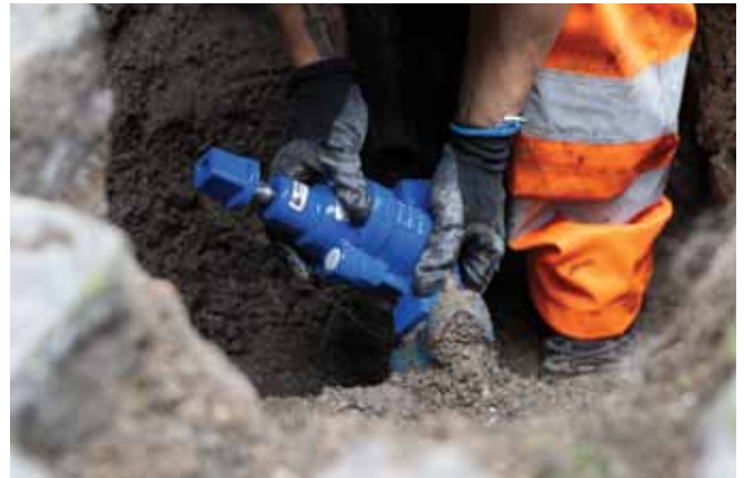
Substituição de condutas
